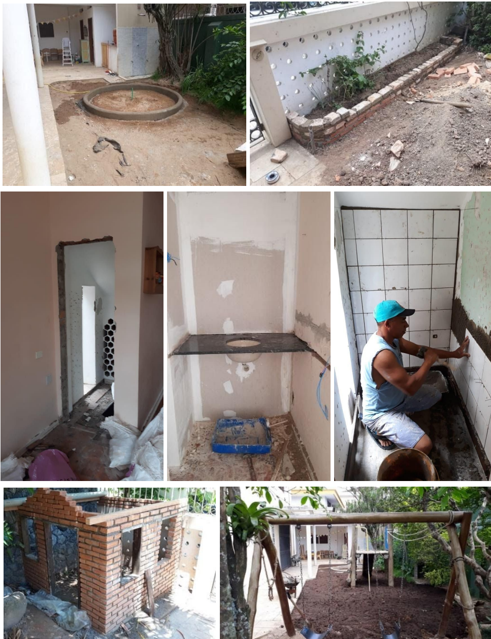
Obras na Unidade II – Educação Infantil - Rua Guaiabê
