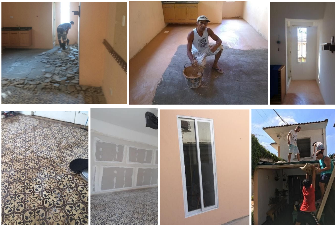
Obras na Unidade I – Ensino Fundamental - Rua Imperatriz Leopoldina
